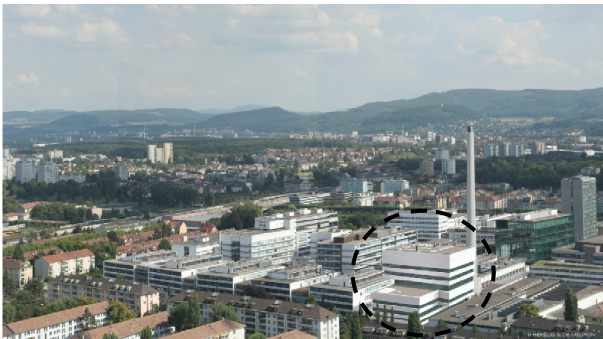
Abb.: Visualisierung geplanter Bau 97 auf dem Areal F. Hoffmann–La Roche (Blick von Nordwesten an die Are-alkante entlang der Wettsteinallee)
