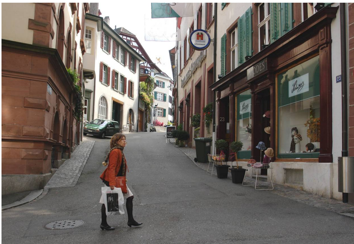
Der Gernsbach heute: Keine Trottoirs und Randpflasterungen den Häusern entlang
