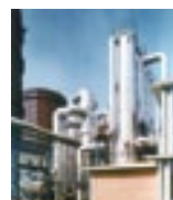
Basel baut eine Gasentgiftungsanlage. Diese wandelt giftiges Kohlenmonoxid in ein gleichwertiges, aber ungiftiges Brenngas um.
