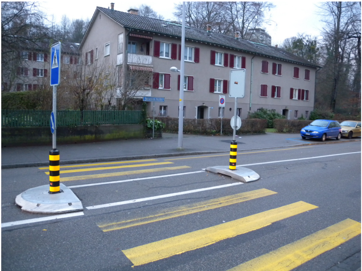
Abbildung 6: heutiger Zustand vom Fussgängerüberweg nördlich Jakobsbergerholzweg
