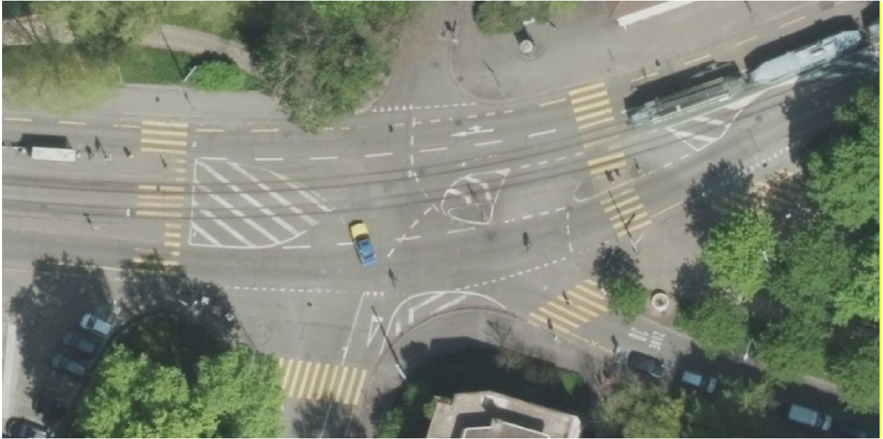
Abbildung 11: Kreuzungsbereich Gellertstrasse/Sevogelstrasse: Die Verkehrsführung mit grossflächigen Sperrmarkierungen ist ein Flickwerk und kann im Zuge der Umgestaltung sicherer gestaltet werden.
