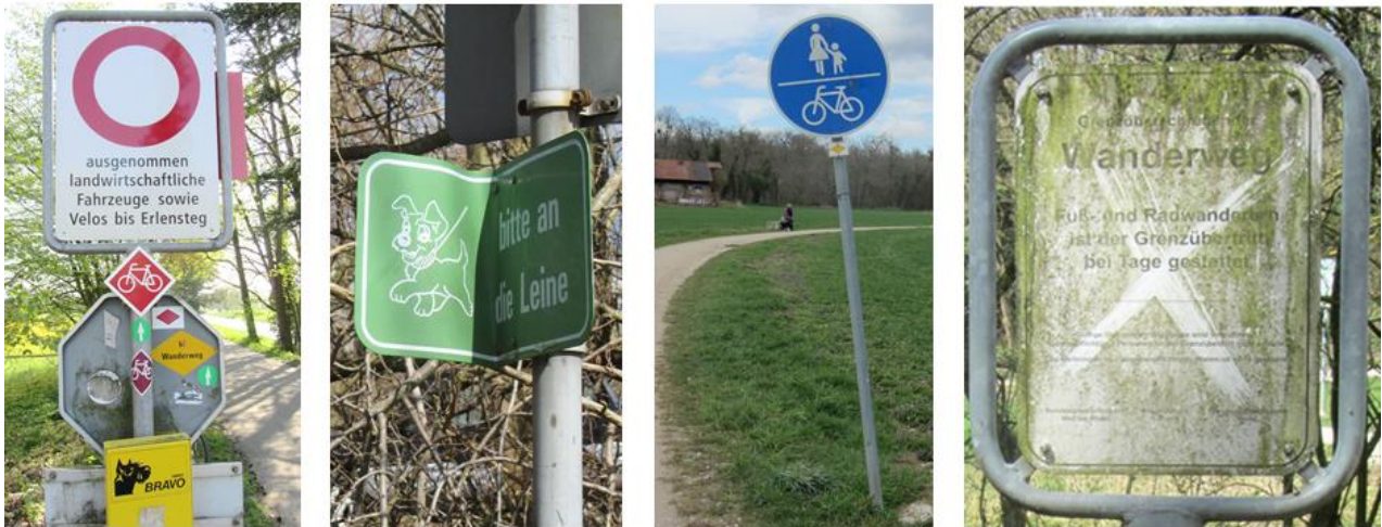
Abbildung 3: Ein Grossteil der Schilder ist defekt, versprayt, verbogen oder steht schief. Bild: Daniel Rüetschi, Beschilderungskonzept.
