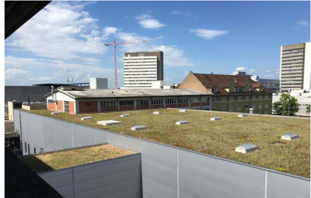
Ansicht von Süden über Bau 207
