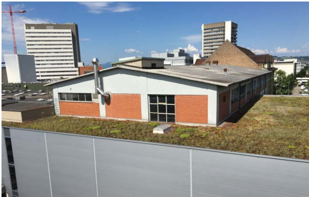
Westseite zukünftige Schule
