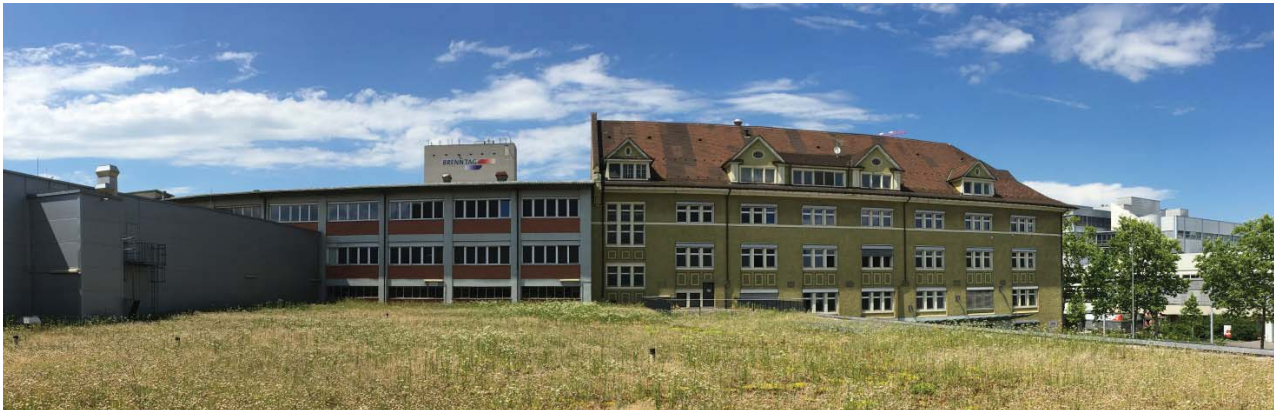
Südfassade Bau 209: linke Seite: best. Lagergebäude > zukünftige Schule, rechte Seite: best. Verwaltungsgebäude > zukünftig Büronutzung
