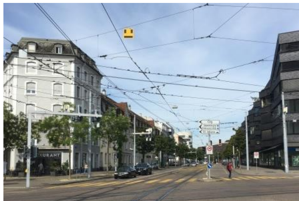
Abbildung 8: Volaplatz, Blick in die Voltastrasse, 2020, Quelle: Planungsamt Basel-Stadt
