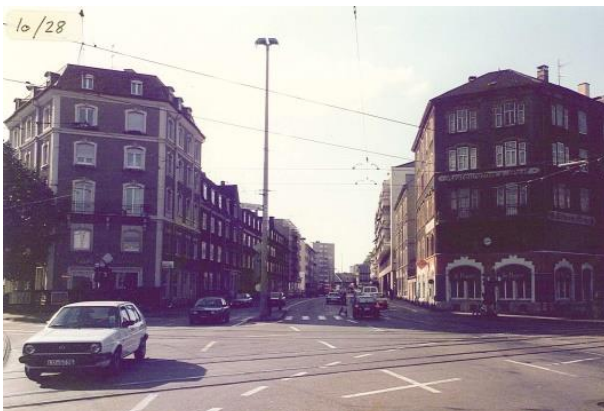
Abbildung 7: Volaplatz, Blick in die Voltastrasse, 1986, Quelle: Planungsamt Basel-Stadt
