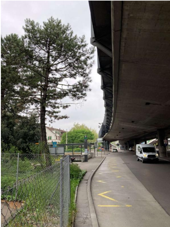
Abbildung 12: Bushaltestelle bei Wettsteinallee
