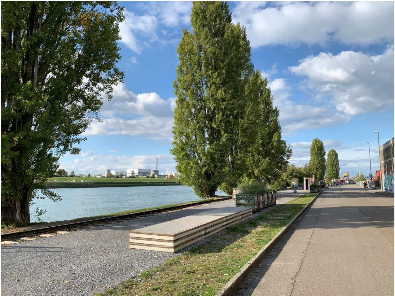
Bild: Instandgesetzte und verbesserte Infrastruktur an der Uferpromenade Klybeckquai
