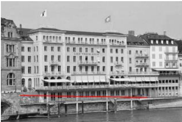
Abb. 6: Ansicht Rampe vor dem Hotel Les Trois Rois
