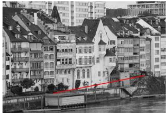
Abb. 7: Ansicht Rampe vor dem Seidenhof
