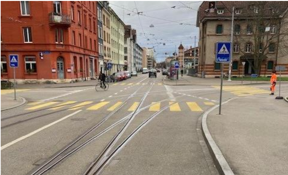
Abbildung 3: Foto der bereits angepassten Markierung zur Verbesserung der Fahrgeometrie im Bereich der Gleisquerung
