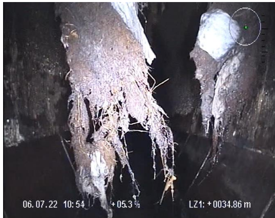
Abb. 5: Wurzeleinwuchs in Kanalisation (Quelle: Tiefbauamt)
